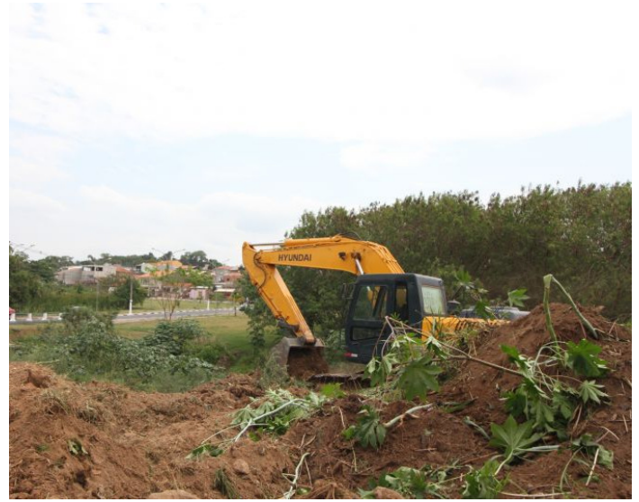
Prefeitura iniciou serviços na área onde será construída nova ponte, no São Sebastião
